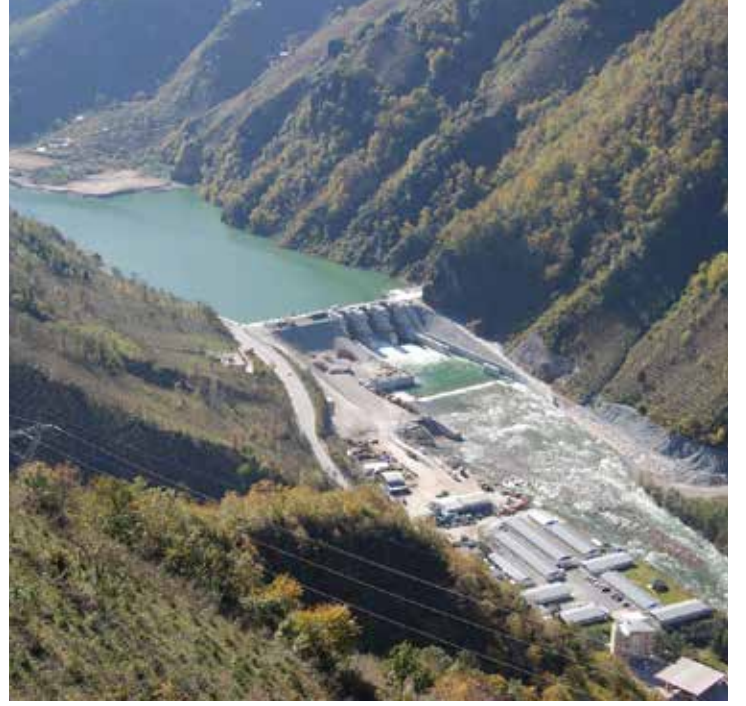
Aslancık Hidroelektrik Santrali, Giresun
