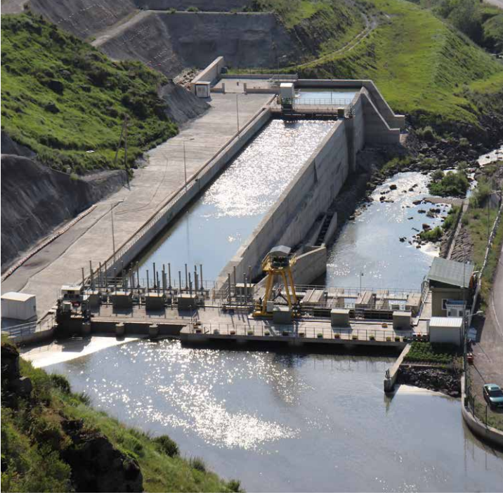
Paravani Hidroelektrik Santrali, Gürcistan
