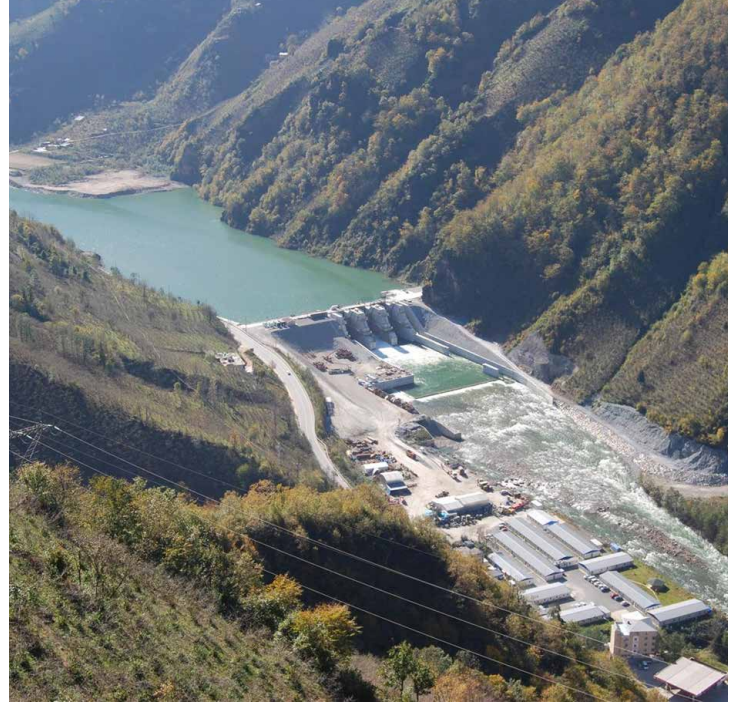
Aslancık Hidroelektrik Santrali, Giresun
